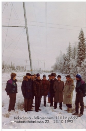
Kokkosniva - Pelkosenniemi 110 kV johdon vastaanottotarkastus 22.-23.10.1992.
