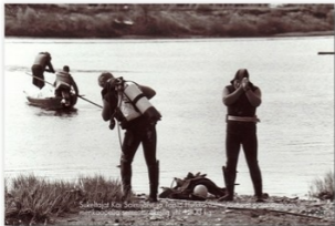
Sukeltajat Kai Salmijärvi ja Tapio Hulkko valmistautuvat painottamaan kaapelia sementtisäkeillä yhteensä 1000 kg. 1990.
