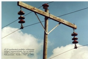
45 kV puolimotorit jouduttiin vaihtamaan kahteen lautaseen, kun ne katkeilivat välillä Kaakkurivaara-Kauhajoki ja Pelkosenniemi-Perälä v. 1987 ja 1992.
