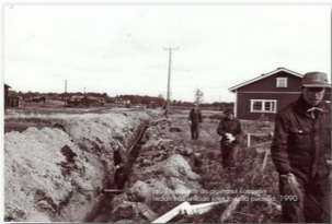
Leo Mettiäinen on aloittanut kaapelin vedon traktorillaan joen toisella puolen 1990.
