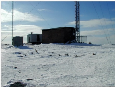
Niekkatunturin linkkiaseman laitetila v 2004. Myrskytuuli sen kaatoi, rattaat poistettiin ja uusi perusta tehtiin.
