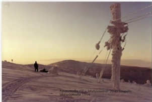
Pyhätunturilla YLE:n lähetyssasema 20 kV kaapelin lähtöpylväs kuvattu 1994.
