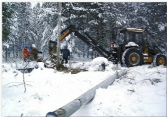
20 kV johdon pylväiden vaihtoa Martti-Lattuna väliillä v. 2005. Kuvassa Kaarlo Pöyliö, Aimo Körkkö ja Jarmo Nikka.
