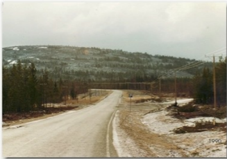
20 kV johto kiertää Sotatunturia 1990.
