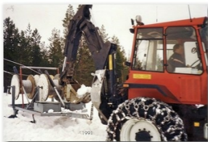
Sakari Ollila vetää johtoja ja nostaa johdot johtopyörille.
