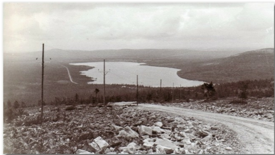
Pyhätunturi, 20 kV johto 1979.
