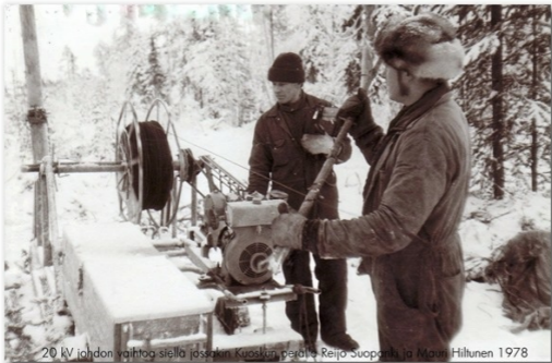
20 kV johdon vaihto siellä jossakin Kuoskun perällä Reijo Suopanki ja Mauri Hiltunen 1978
