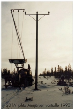
20 kV johto Ainijärven vartiolle 1990. Sakari Ollila asentamassa johtoja.
