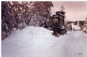
Sakari Ollila puskee tietä johdonrakennustyömaalle 1991.
