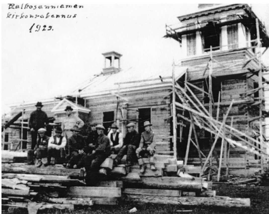
Kuva 4. Pelkosenniemen kirkon rakennustyömaa 1929. Seisomassa vasemmalla rakennusmies Alpertti Hakkarainen, vieressä valvova rakennusmestari Lauri Saarinen. Istumassa oikealla poika Oulusta, Johan Myllys, Olli Pöykkölä ja Erkki Ranta. Kuvassa mahdollisesti Myös Aleks ja Eemeli Tähjängöki Raahesta. Muita ei tunnistettu. Kuva L. Saarinen.
